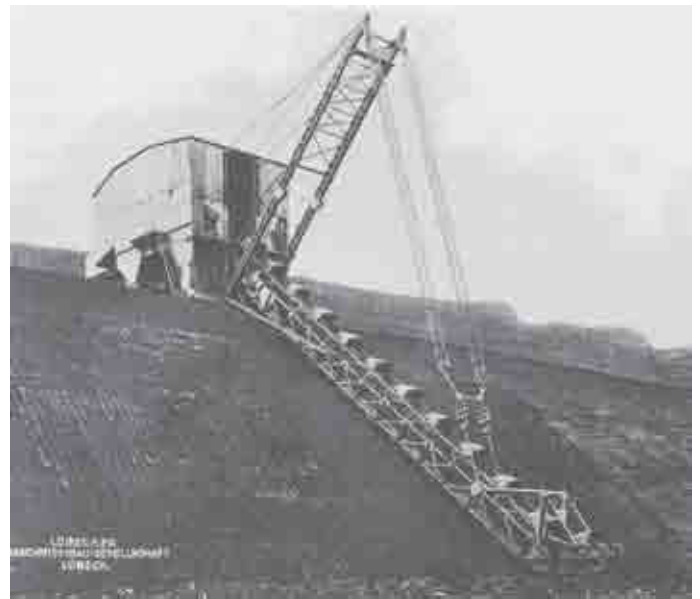
Abb. 5 Eimerkettenbagger bei der Kohलगewinnung. Foto 1913 (aus: „Braunkohlenbergbau im Rheinland“. Wernersche Verlagsgesellschaft, Worms 2008)
